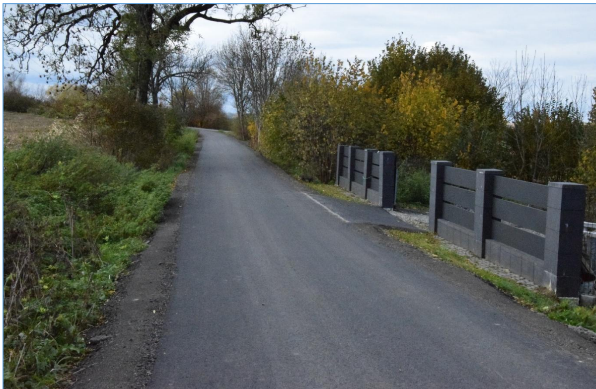
Zdjęcie 15. Remont ul. Osiedlowej w Roztropicach
