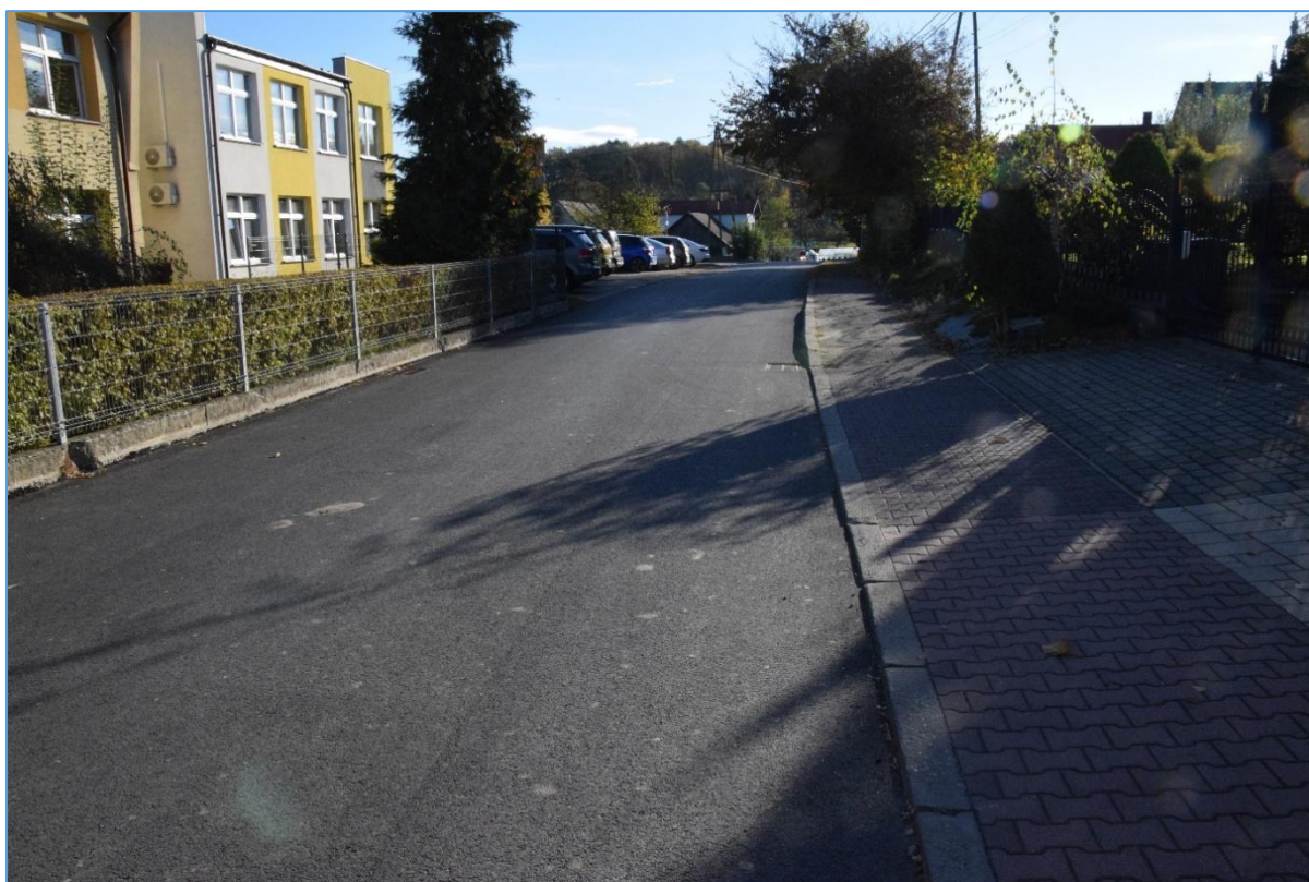
Zdjęcie 16. Remont ul. Szkolnej w Międzyrzeczu Górnym
