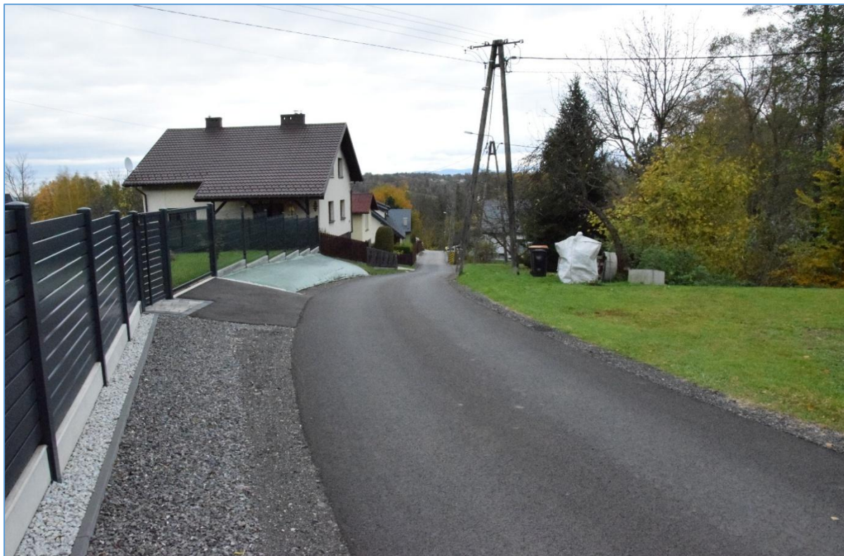
Zdjęcie 14. Remont ul. Do Dziedziny w Bielowicku
