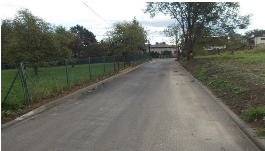
Fot. 7 Remont drogi gminnej ul. Spacerowej w Kończycach Małych
