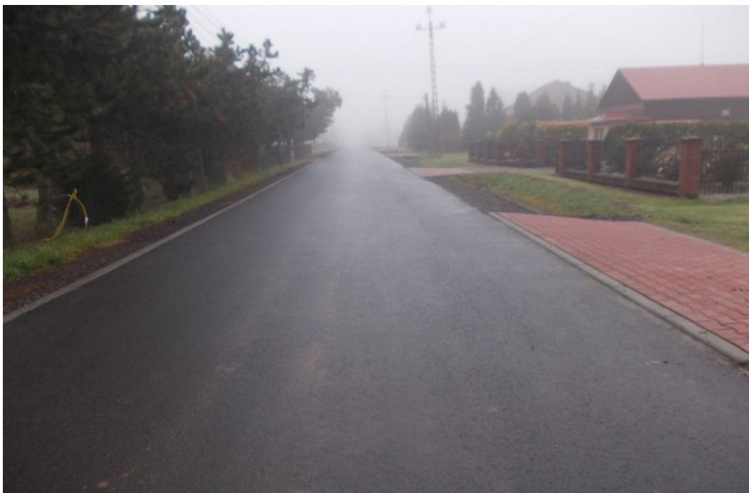
Fot. 9 Przebudowa ul. Jesionowej w Zebrzydowicach
