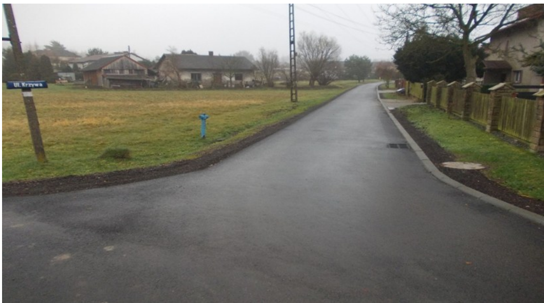
Fot. 13 Przebudowa drogi gminnej ul. Krzywej w Markłowicach Górnych
