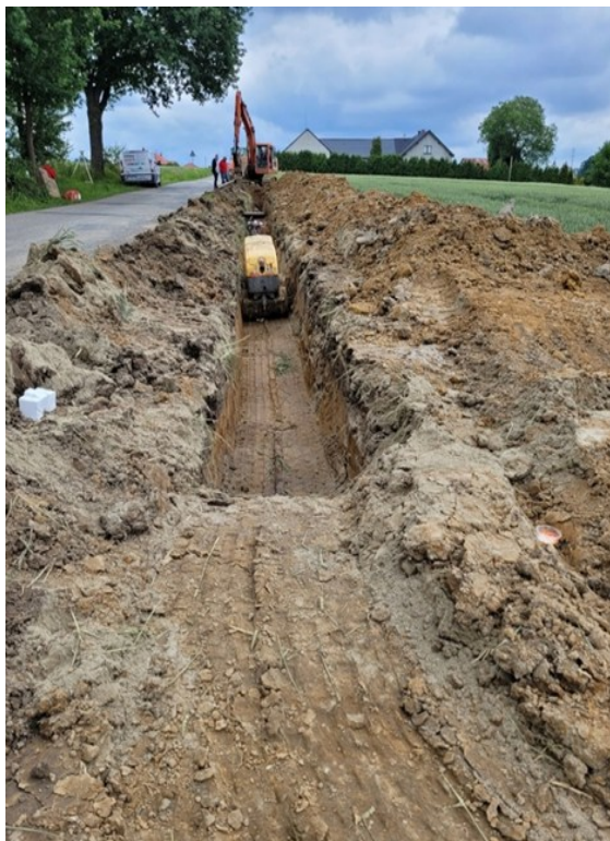
Fot. 1 Prace ziemne związane z budowaną kanalizacją sanitarną
