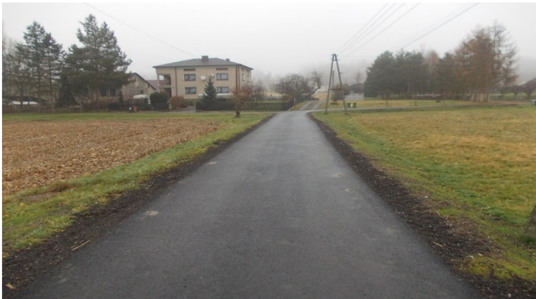
Fot. 14 Przebudowa drogi bocznej od ul. Szkolnej w Markłowicach Górnych
