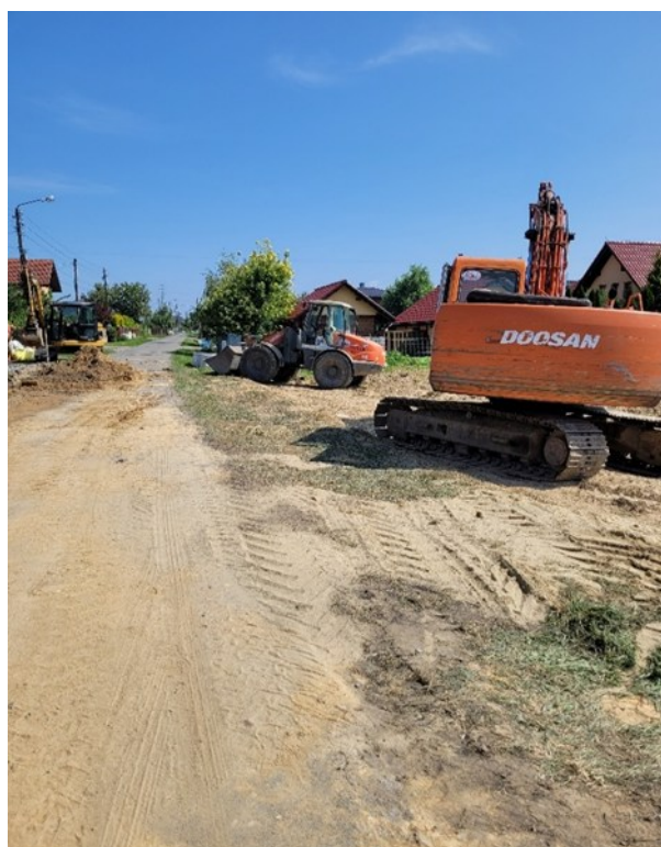
Fot. 1 Prace ziemne związane z budowaną kanalizacją sanitarną
