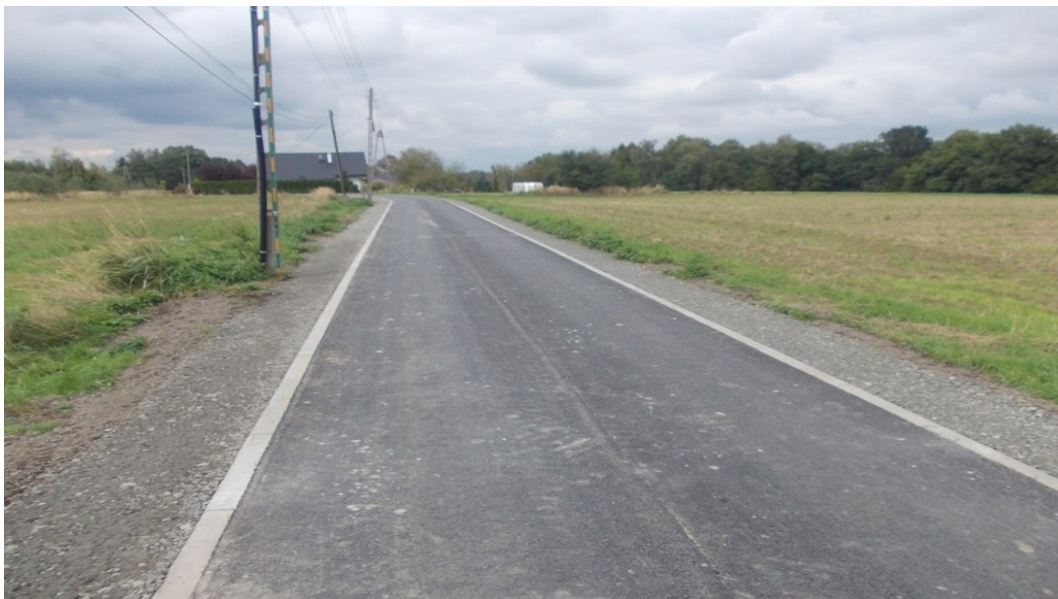
Fot. 6 Przebudowa ul. Brzoskwiniowej w Kończycach Małych
