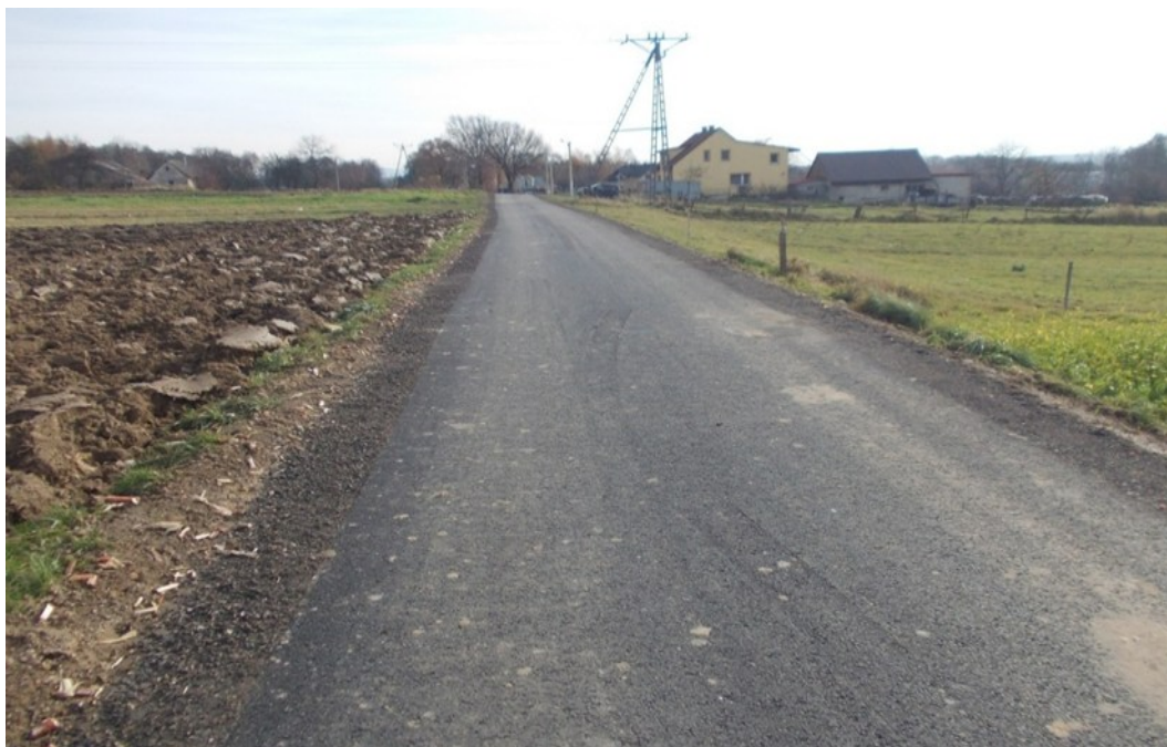
Fot. 4 Przebudowa drogi bocznej od ul. Otrębowskiej w Kaczycach
