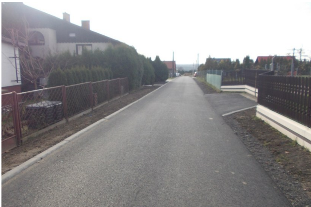
Fot. 5 Przebudowa drogi bocznej ul. Sobieskiego w Kaczycach
