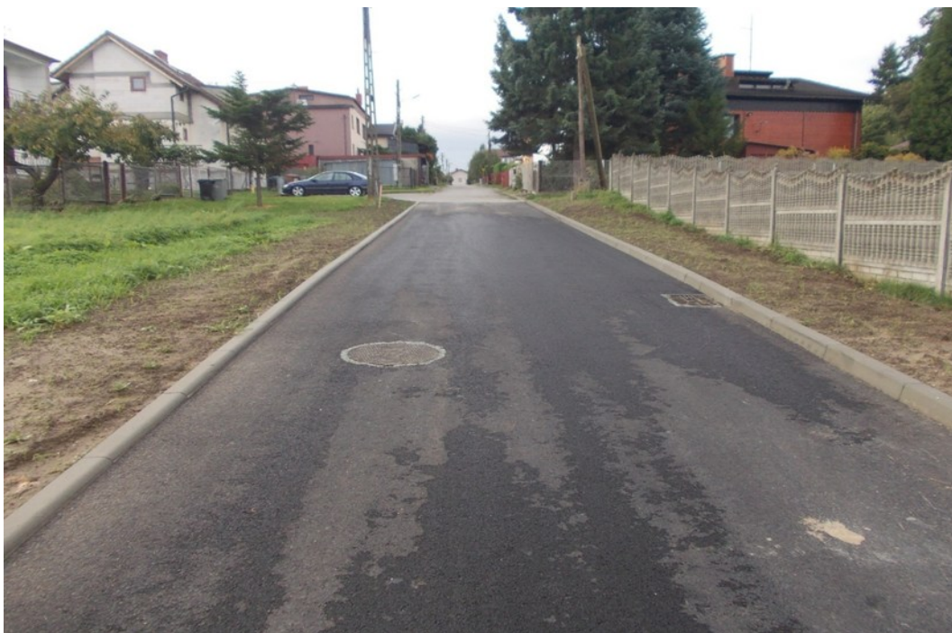
Fot. 8 Przebudowa łącznika ul. Spacerowej z ul. Staffa w Kończycach Małych
