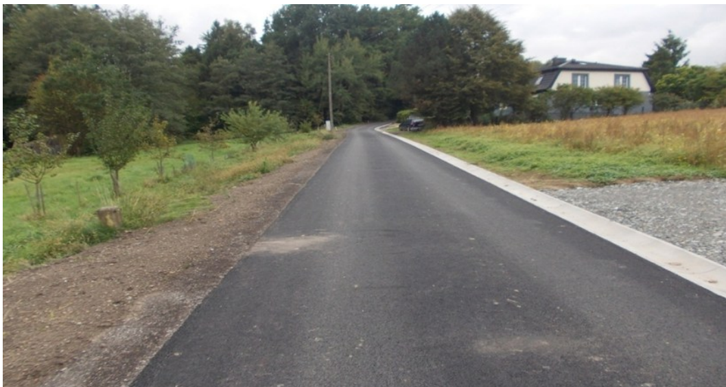
Fot. 11 Przebudowa drogi bocznej od ul. Dworcowej w Zebrzydowicach
