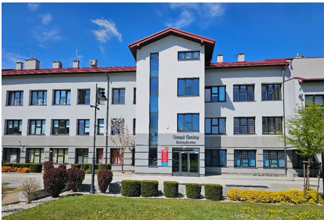
Fot. 3 Widok odnowionej elewacji budynku
