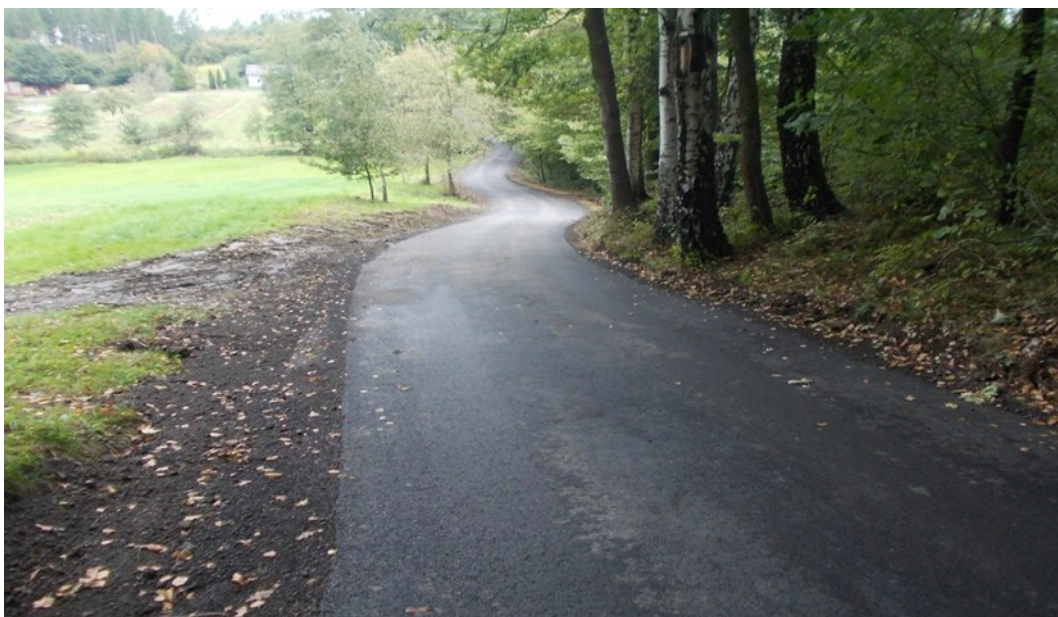
Fot. 12 Przebudowa ul. Lipowej w Markłowicach Górnych
