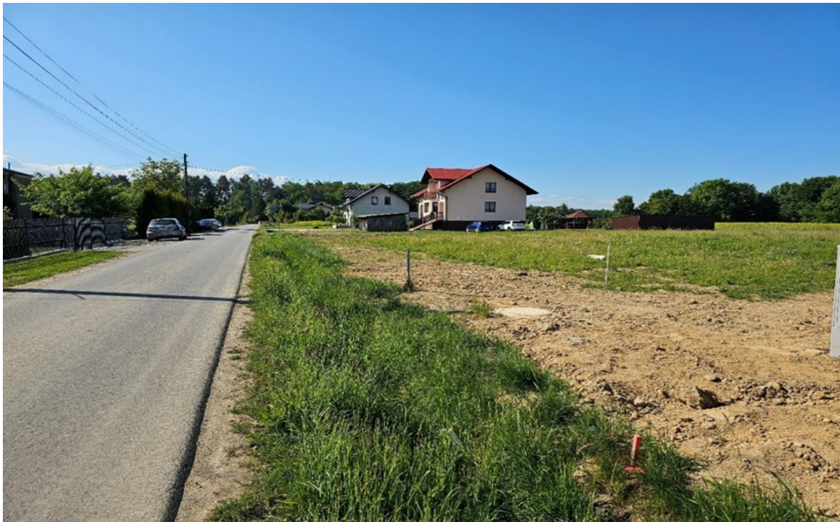
Fot. 2 Teren po wykonanych robotach kanalizacyjnych
