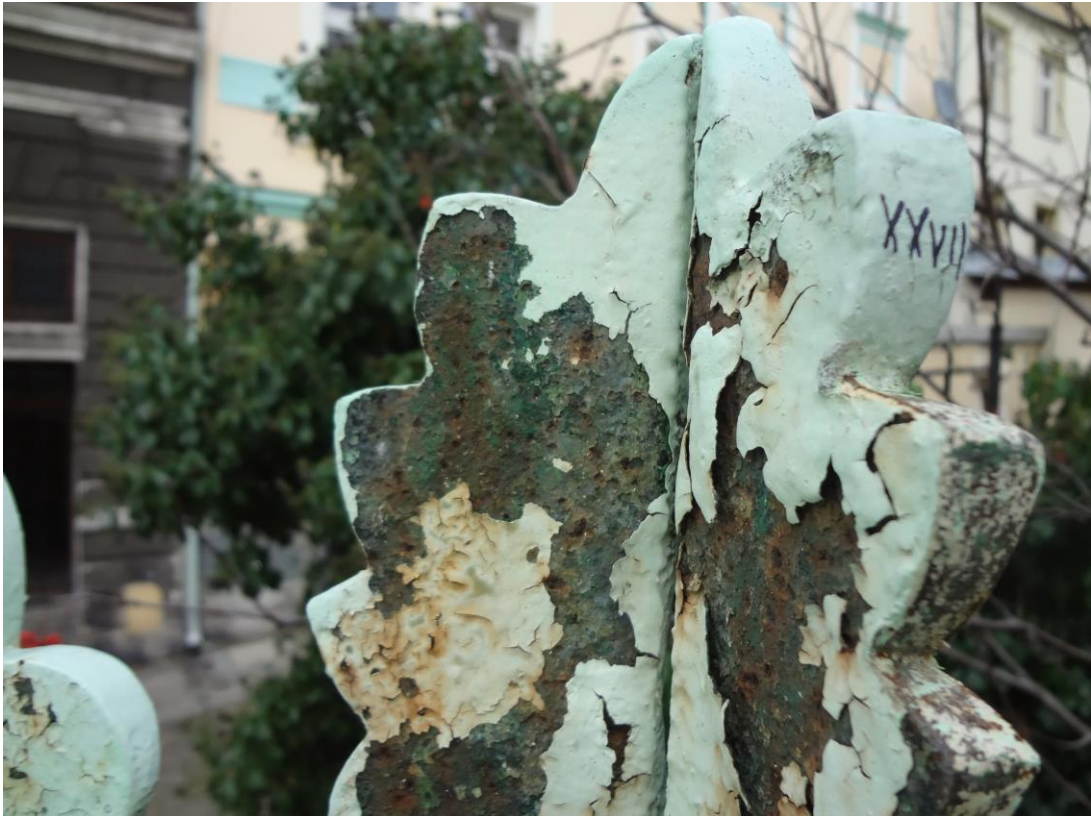
FOT. 36 - CIESZYN, STUDNIA TRZECH BRACI - odkrywki w partii łączenia żeliwnych elementów dekoracji nad okapem dachu.
