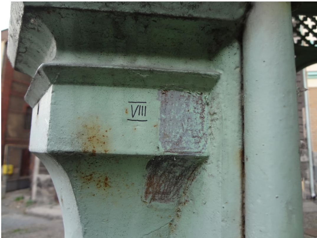
FOT. 18 - CIESZYN, STUDNIA TRZECH BRACI - odkrywka w partii kapitelu kolumny otwartego przęsła centralnego.
