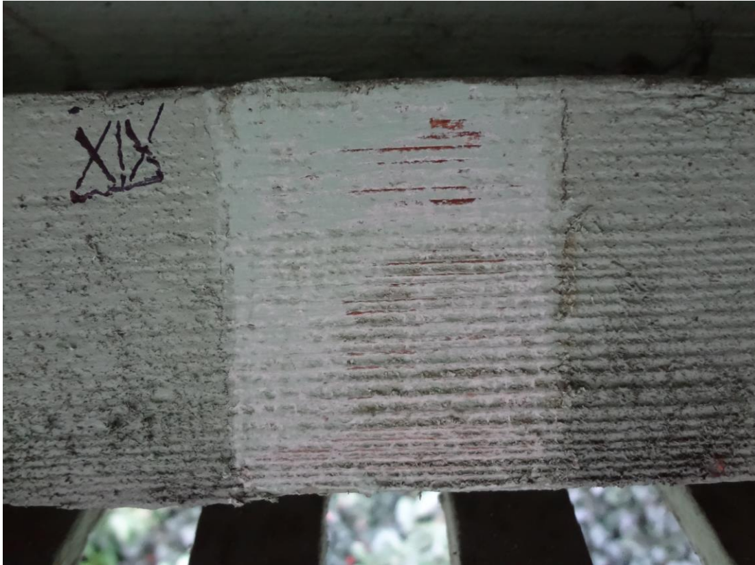
FOT. 29 - CIESZYN, STUDNIA TRZECH BRACI - odkrywka na drewnianych elementach więzby dachowej – dolna belka ( murlata ).
