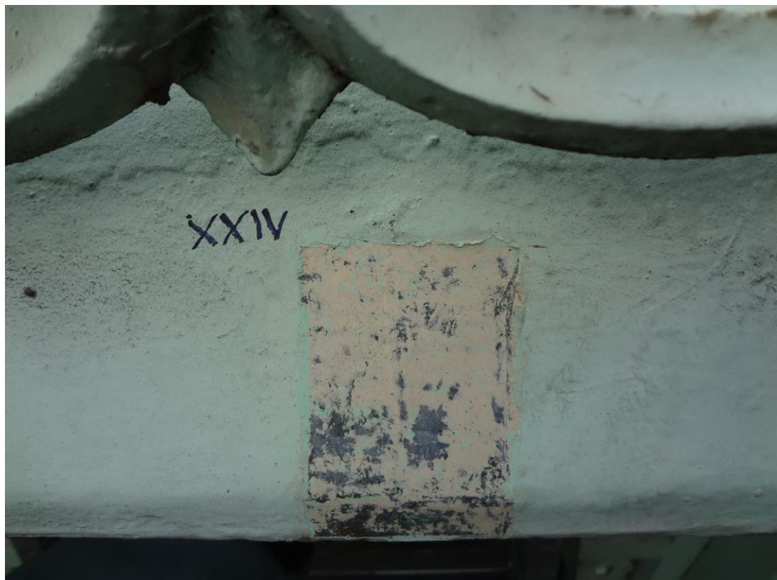
FOT. 34 - CIESZYN, STUDNIA TRZECH BRACI - odkrywka na krawędzi okapu pokrycia dachowego poniżej żeliwnej dekoracji dachu.
