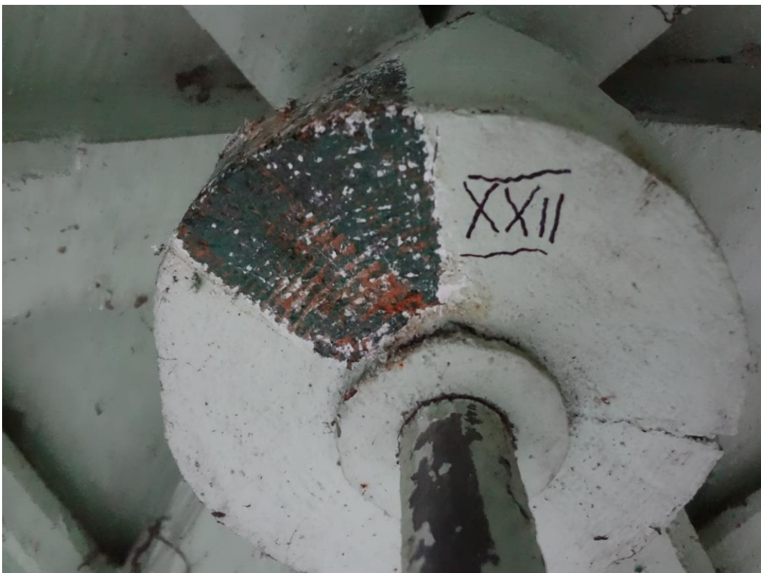
FOT. 32 - CIESZYN, STUDNIA TRZECH BRACI - odkrywka na drewnianych elementach więźby dachowej – centralny zwornik sklepienia.
