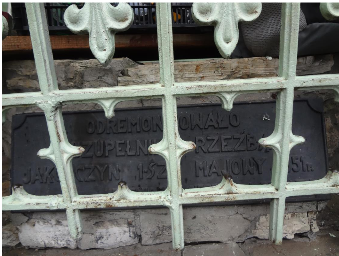
FOT. 39 - CIESZYN, STUDNIA TRZECH BRACI - tablica pamiątkowa z 1951 r. wewnątrz dolnej części centralnego, otwartego przęsła.
