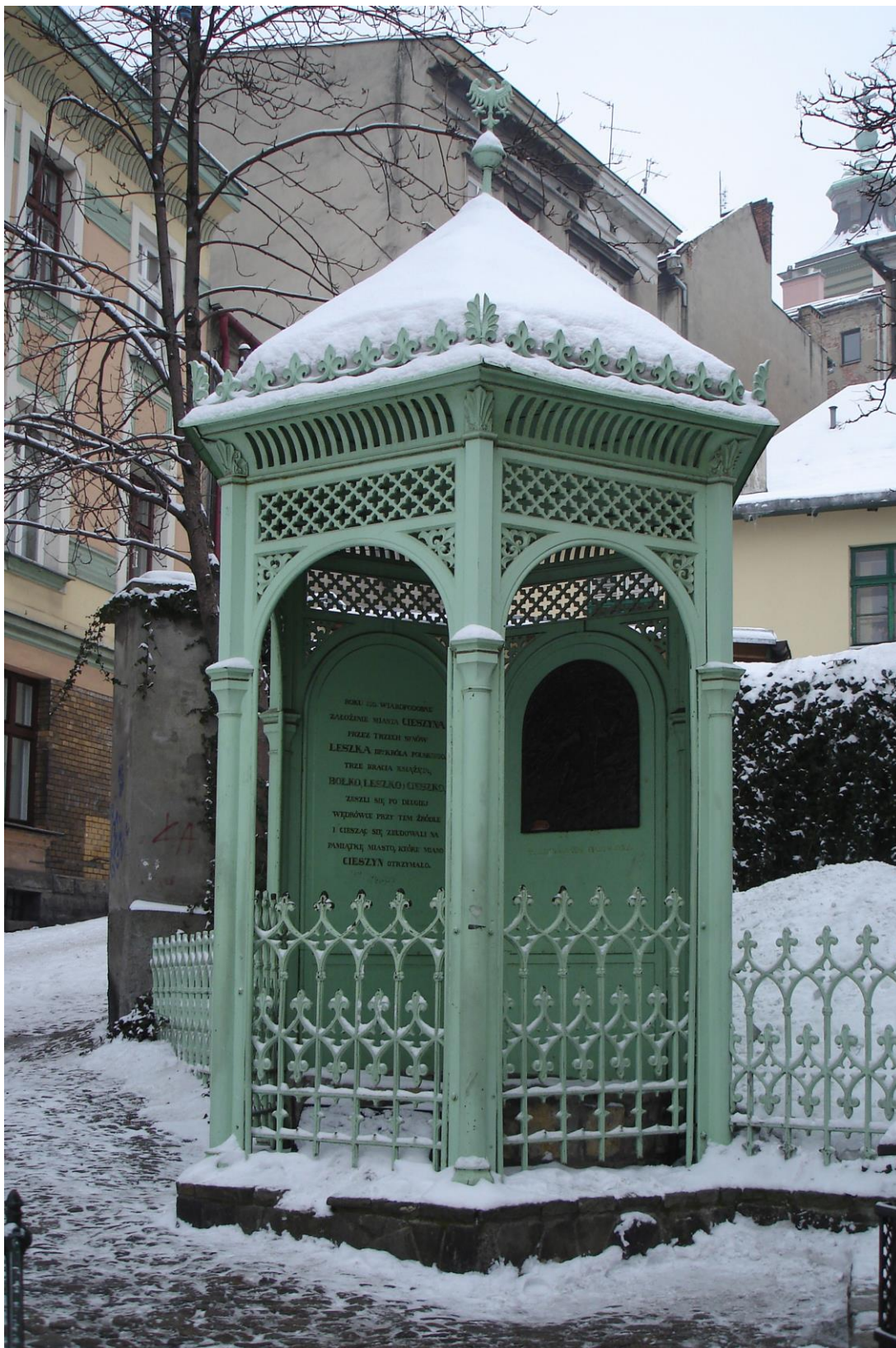
FOT. 9 CIESZYN, STUDNIA TRZECH BRACI - obiekt w lutym 2010 r.
