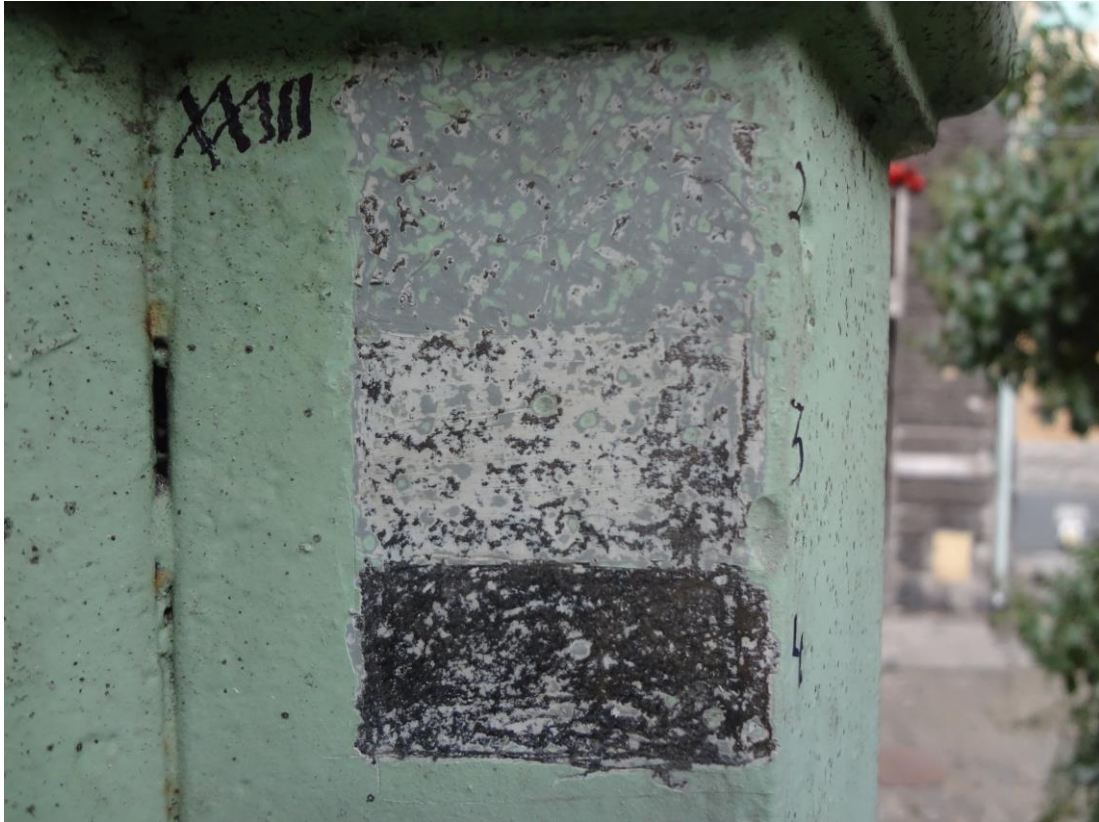
FOT. 33 - CIESZYN, STUDNIA TRZECH BRACI - sonda stratygraficzna w górnej części zewnętrznego filara z tyłu studni.
