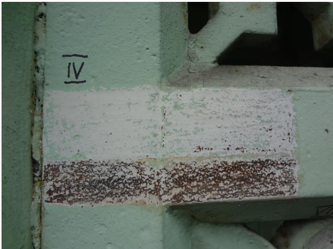
FOT. 14 - CIESZYN, STUDNIA TRZECH BRACI - sonda stratygraficzna na ramie Poniżej ażurowej płyciny nad łukiem między kolumnami.
