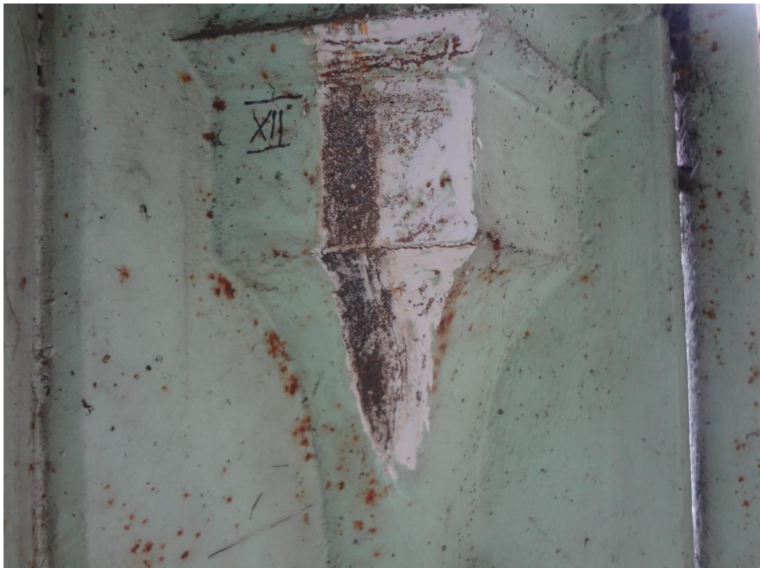
FOT. 22 - CIESZYN, STUDNIA TRZECH BRACI - odkrywka na wewnętrznym kapitelu lewej kolumny otwartego przęsła centralnego.
