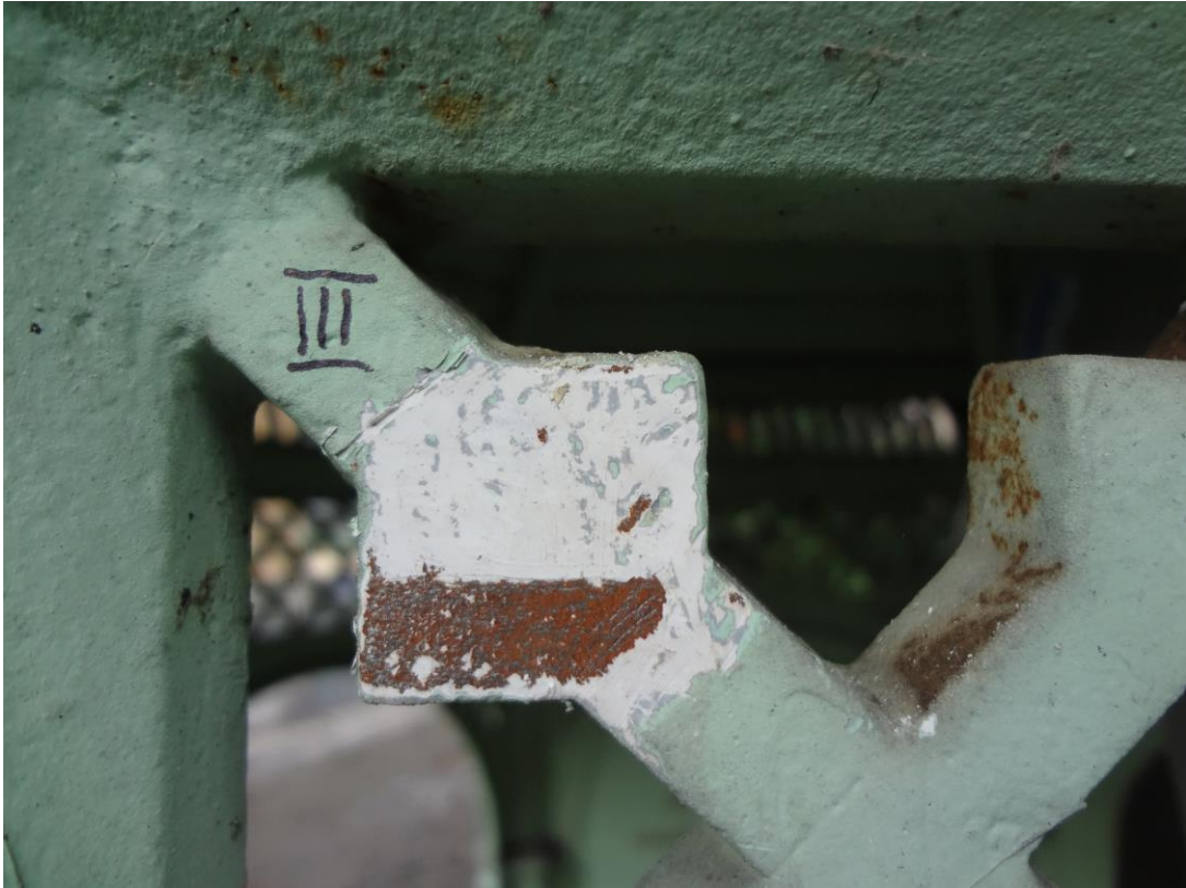
FOT. 13 - CIESZYN, STUDNIA TRZECH BRACI - sonda stratygraficzna w partii ażurowej płyciny nad łukiem między kolumnami.
