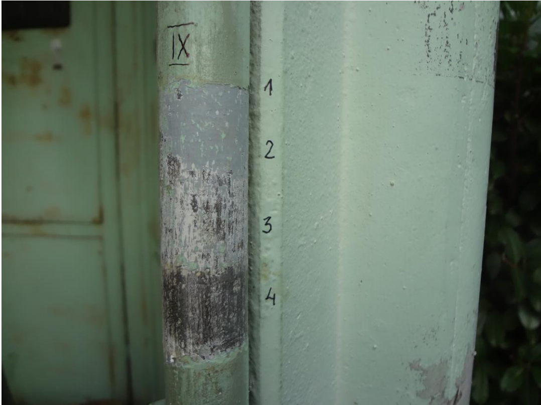
FOT. 19 - CIESZYN, STUDNIA TRZECH BRACI - sonda stratygraficzna w partii wałka w łuku między kolumnami prawego, otwartego przęsła.
